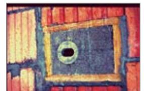
▲ zur Verhinderung von Kältebrücken (Isolierung bauseits)
